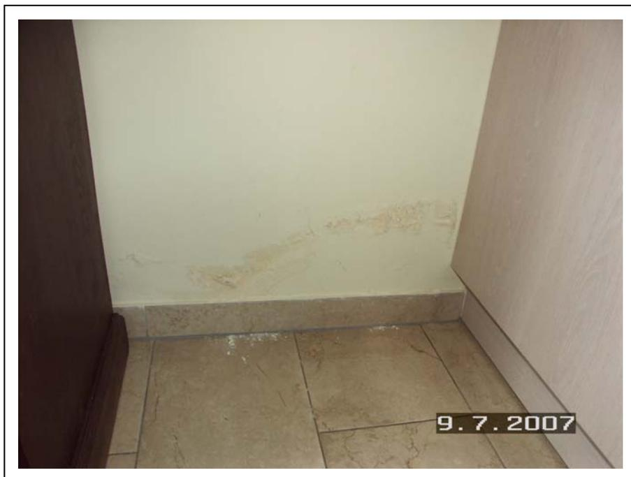
Bild 40 Feuchteschäden an der Innenwand im Erdgeschoss an der Nordseite des Wohnhauses
