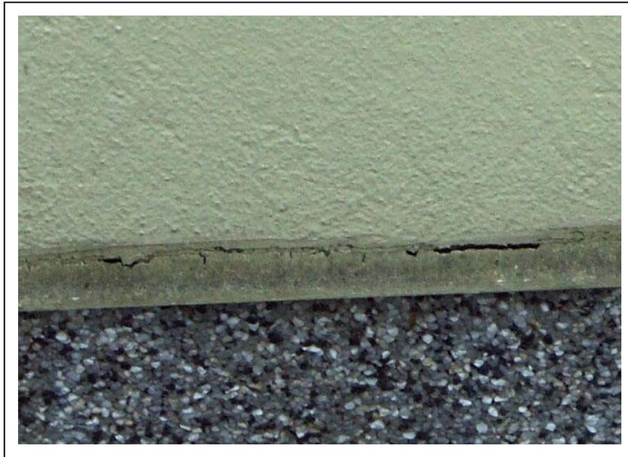
Bild 39 Risse zwischen dem Außenwandputz und dem Sockelbuntputz, möglicherweise Ursache der Feuchteschäden an der Innenwand im Erdgeschoss
